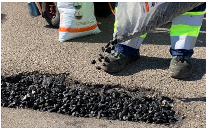
Legg flere lag om hverandre med ChipFill og AggreFill for optimal binding.
