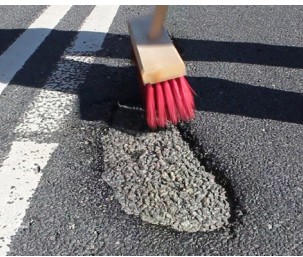
Rengjør hullet godt med en kost.
