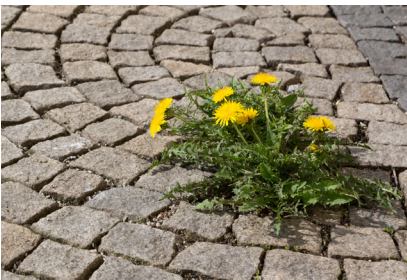
Forhindre vekst av ugress mellom brostein.
