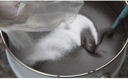
Bland sammen de to komponentene godt med en drill og en visp.
