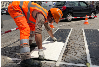
Levelering av overflater før applisering av Premark eller Decomark.
