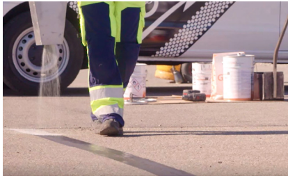
Strø på knust glass når blandingen fortsatt er våt for god sklisikring.
