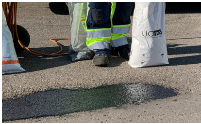
Rask herdetid gjør at trafikken kan gjenåpnes etter bare 20 min.
