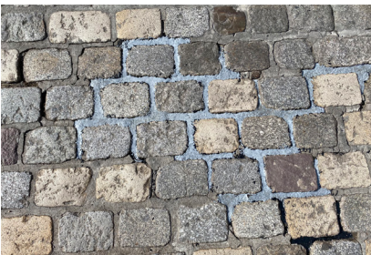
Forhindre utvasking mellom brostein.
