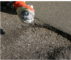
Påfør et jevnt lag med maks 15mm ChipFill. Varm opp materialet slik at det smelter skikkelig.
