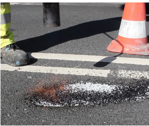
Legg flere lag med maks 15mm og smelt Chipfill for å fylle opp skaden. Strø med friksjonsglass til slutt for anti-skli egenskaper.
