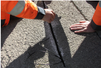
Overflaterreparasjon etter gjennomføringer av kabler gjennom asfalten.
