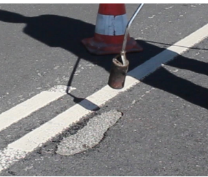
Fjern all fukt fra hullet ved å varme hullet godt opp med gassbrenneren.
