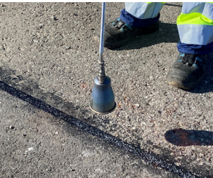
Fest BandFill til området ved å smelte det med en gassbrenner til det bobler rolig.
