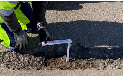
Enkel reparasjon av skader med dybde mellom 25-60mm
