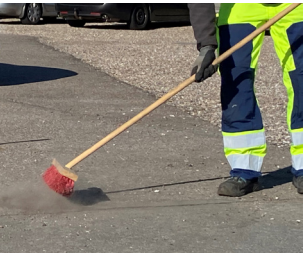
Kost bort all løs skit, og fjern all fukt i sprekken med en gassbrenner.
