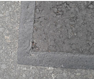
Ideelt til å reparere overganger hvor det er lagt ny asfalt inn mot gammel asfalt for å unngå vanninntregning.
