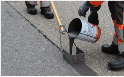
Bruk en skrapeboks/skope ved påføring langs en lang sprekk eller fuge.
