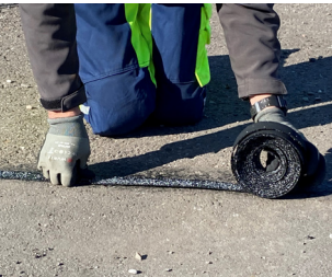
Rull ut BandFill slik at det følger sprekken eller fugen hvor det skal påføres.
