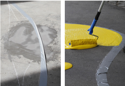
Rette opp ujevne områder før applisering av RollGrip eller RollPlast.
