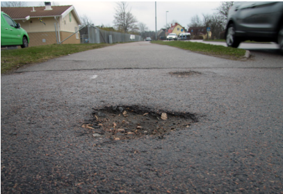
Reparasjoner av fortau og sykkelstier for å hindre potensielle skader på myke trafikanter.
